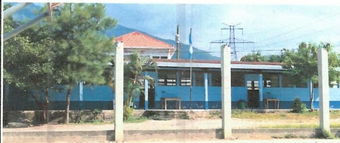
Foto1: MEJORAMIENTO DE CUBIERTA DE LAMINA TROQUELADA CALIBRE 26
